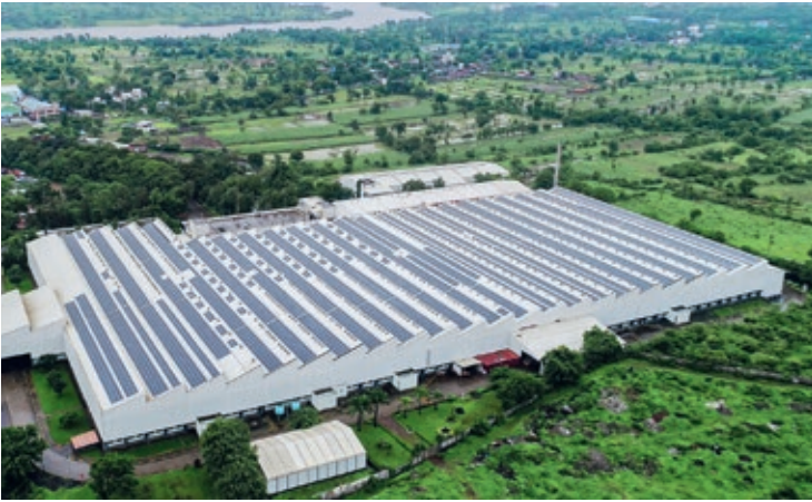
Die Solaranlage von Rieter India liefert 25% des jährlich benötigten Stromverbrauchs und reduziert den CO 2 -Ausstoss um 2 500 Tonnen/Jahr.
