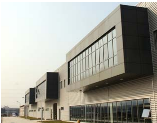
Rieter Changzhou Werk 2 – Büros und Kantine
